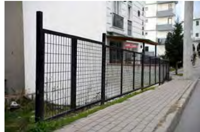
Yol Kenarı Demir Korkuluk Çalışması
