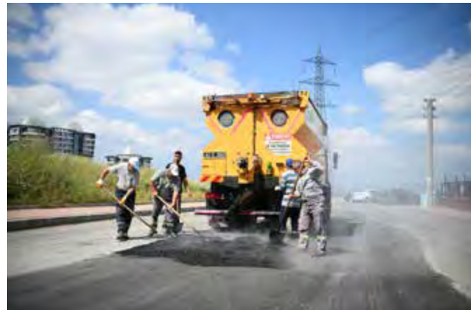
Asfalt Yama Çalışması
