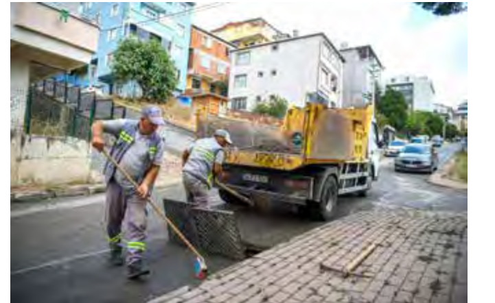
Yağmur Suyu Izgarası Temizliği
