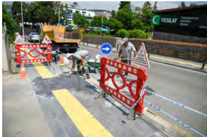
Yaya Yolu Kaldırım Tamirâtı
