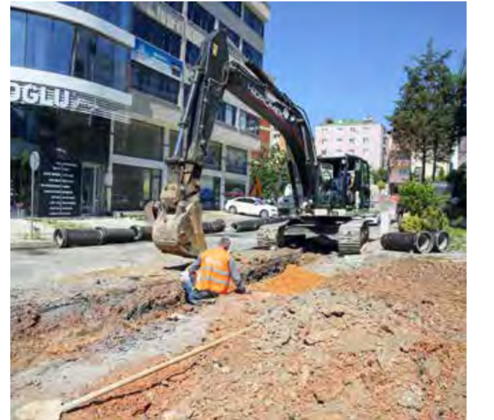
Yağmur Suyu Hattı Yapımı
