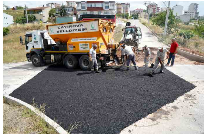
Asfalt Yama Çalışması
