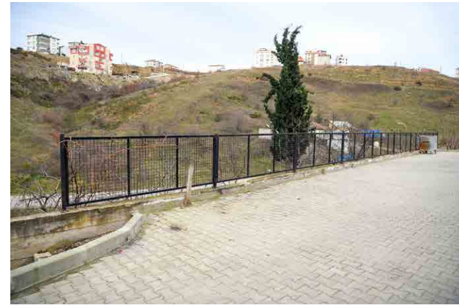
Yol Kenarı Demir Korkuluk Çalışması
