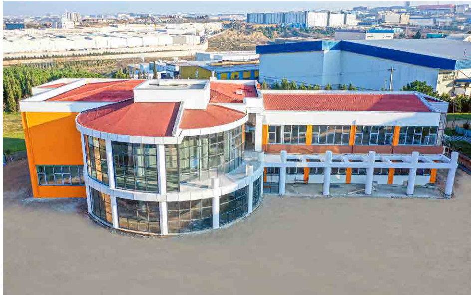
Engelli Yaşam Merkezi İnşaatı ◀
