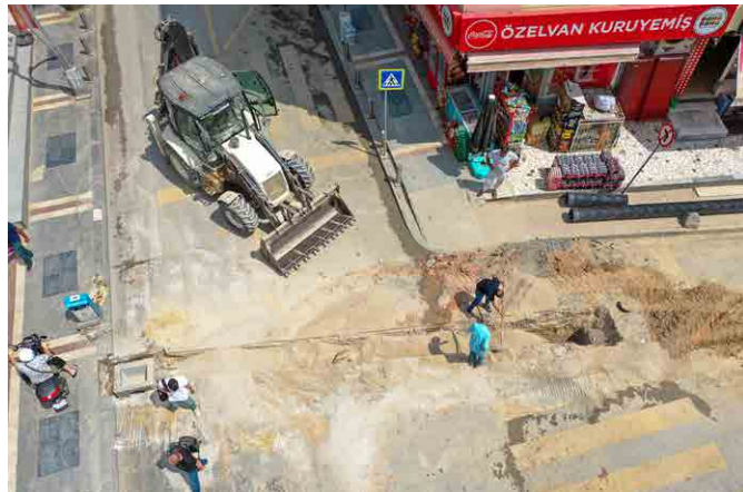
Yağmur Suyu Hattı Çalışması
