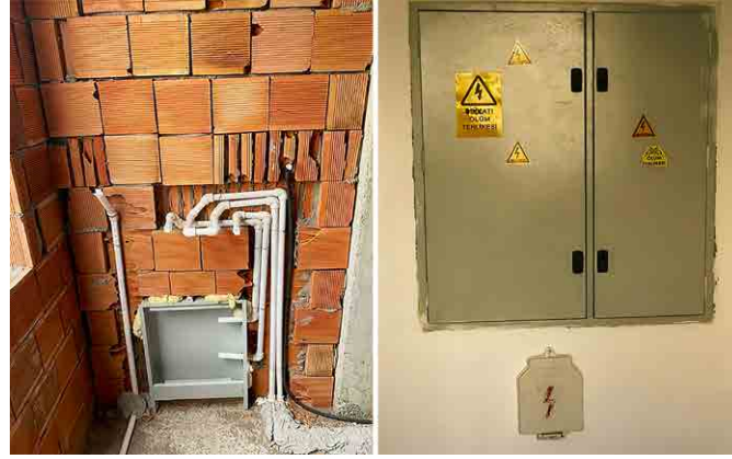
(Mekanik ve Elektrik Tesisatı Kontrolleri Örnek Fotoğrafları)
