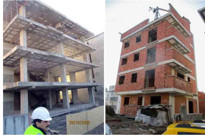
(%60 Seviye Kontrolü Örnek Fotoğrafı) (%80 Seviye Kontrolü Örnek Fotoğrafı)
