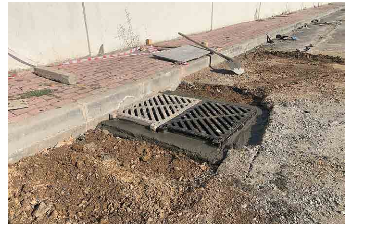
Yağmur Suyu Izgarası Montajı
