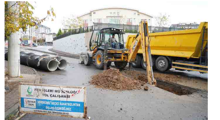
Yağmur Suyu Hattı Yapımı
