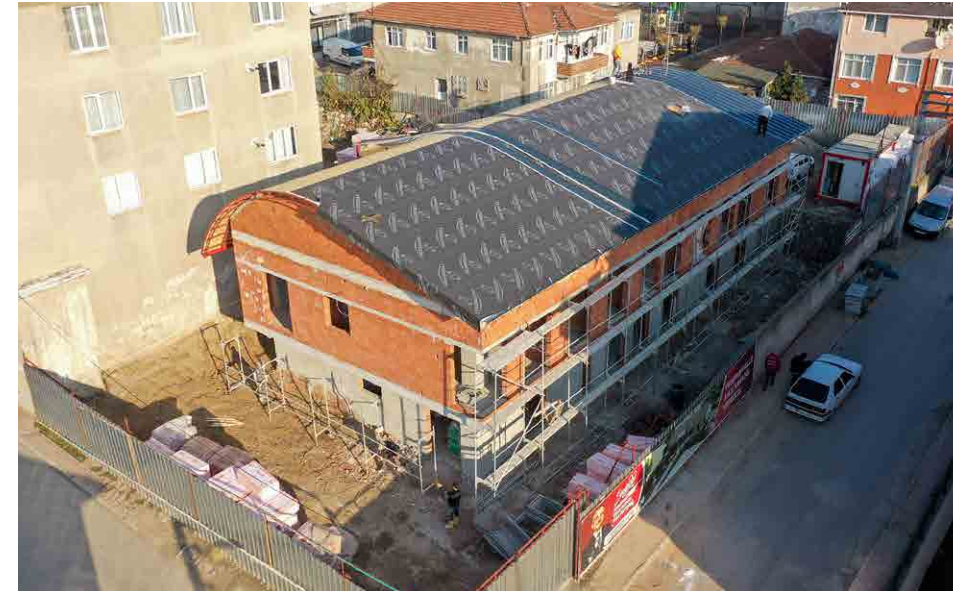
► Yenimahalle Sağlık Ocağı ve Muhtarlık Binası İnşaatı
