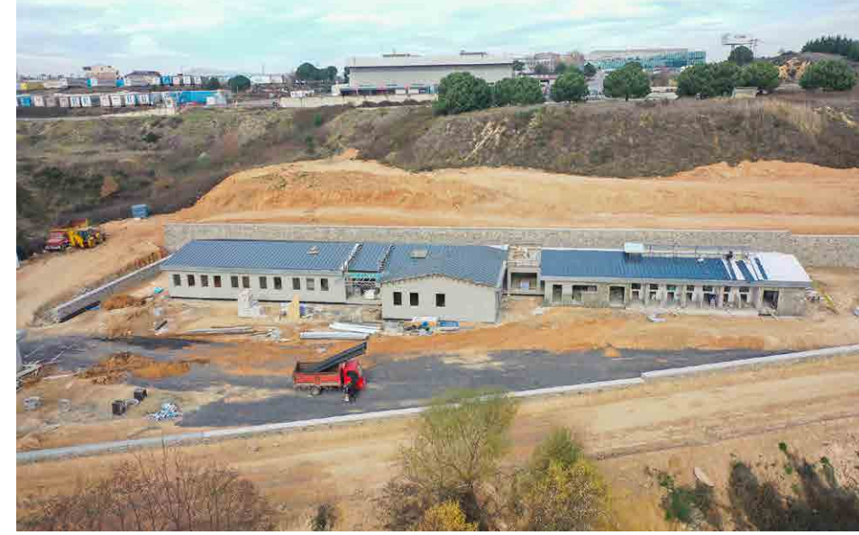
► Sokak Hayvanları Geçici Bakım Evi ve Rehabilitasyon Merkezi İnşaatı
