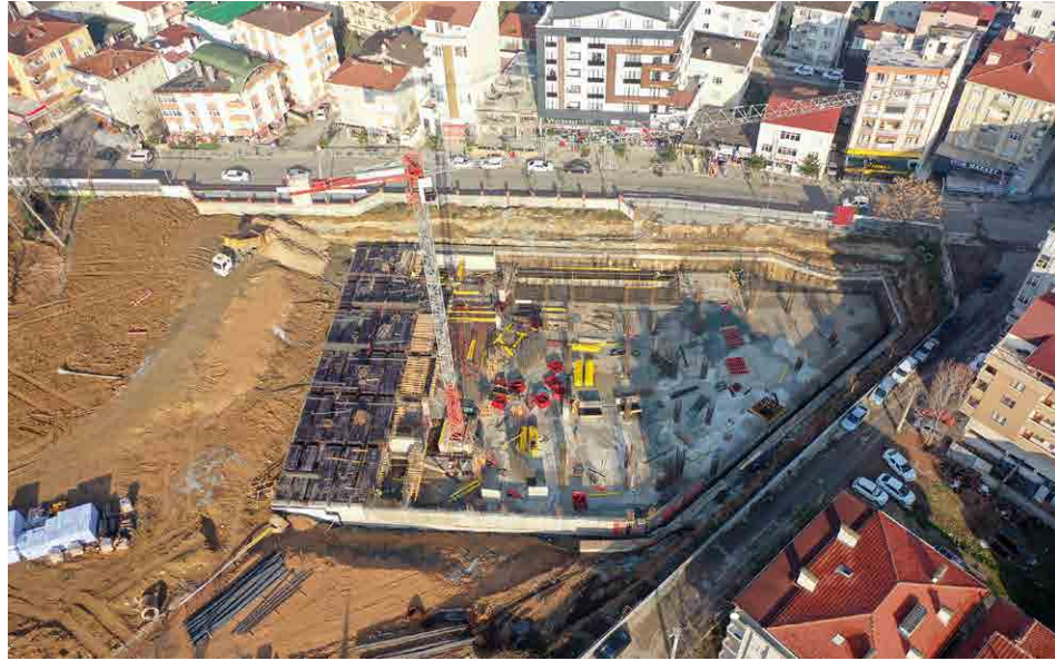
► Kent Meydanı ve Camii İnşaatı
