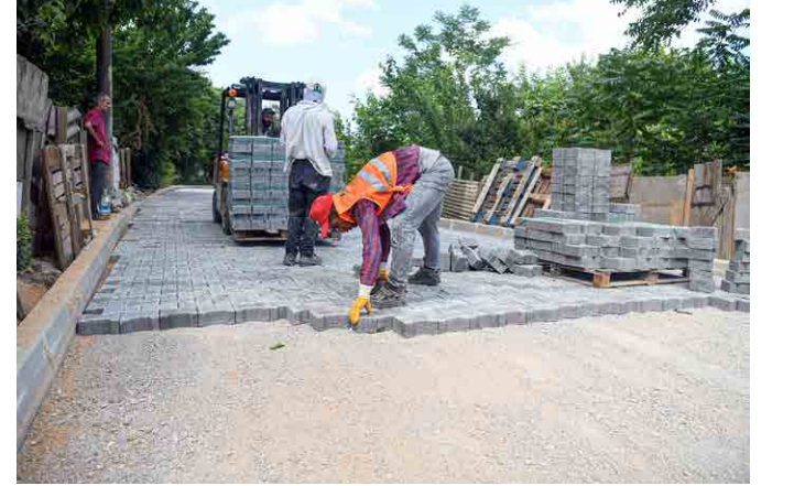
Yol Yüzeyine Parke Taşı Çalışması
