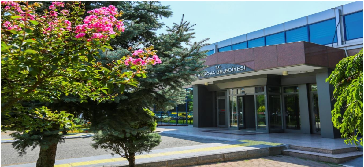
Çayırova Belediyesi Merkez Hizmet Binası
